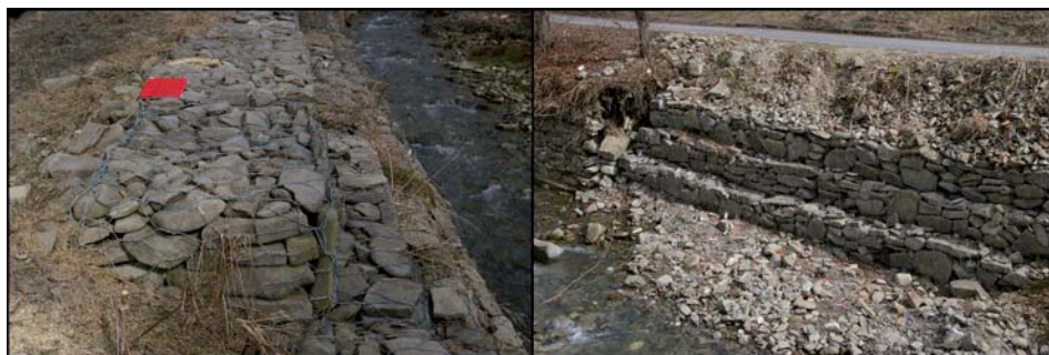
Rys. 4. Umocnienia siatkowo-kamienne w potoku Jamne Fig. 4. Gabions in the channel of Jamne stream
