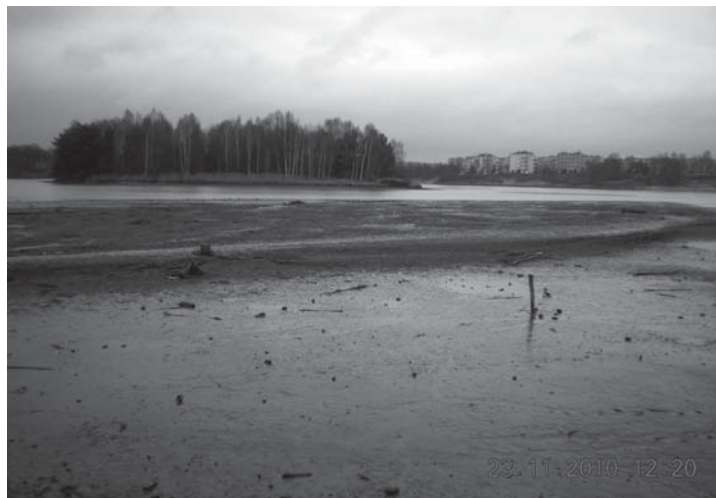
Rys. 7. Materiał odłożony w części wlotowej do zbiornika – widok z prawego brzegu Fig. 7. Material deposited in the inlet to the reservoir – the view from the right edge
