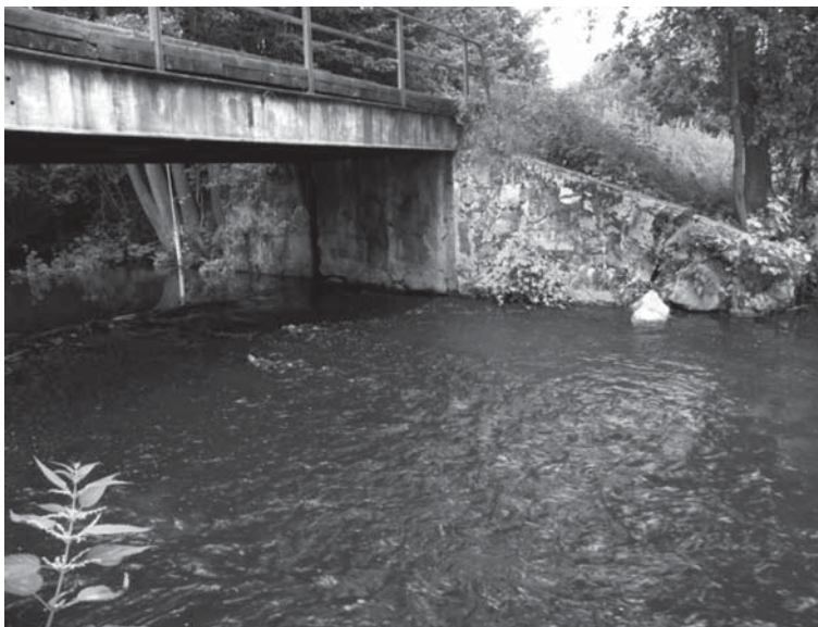
Rys. 2. Widok mostu od strony wody dolnej Fig. 2. View of the bridge from tailwater side
