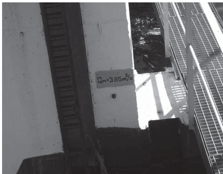
Rys. 2. Przykład zaznaczonego na jazu wymaganego otwarcia zasuwy dla przepuszczania przepływu nienaruszalnego w okresie przerw w pracy elektrowni (fot. D. Libront)
