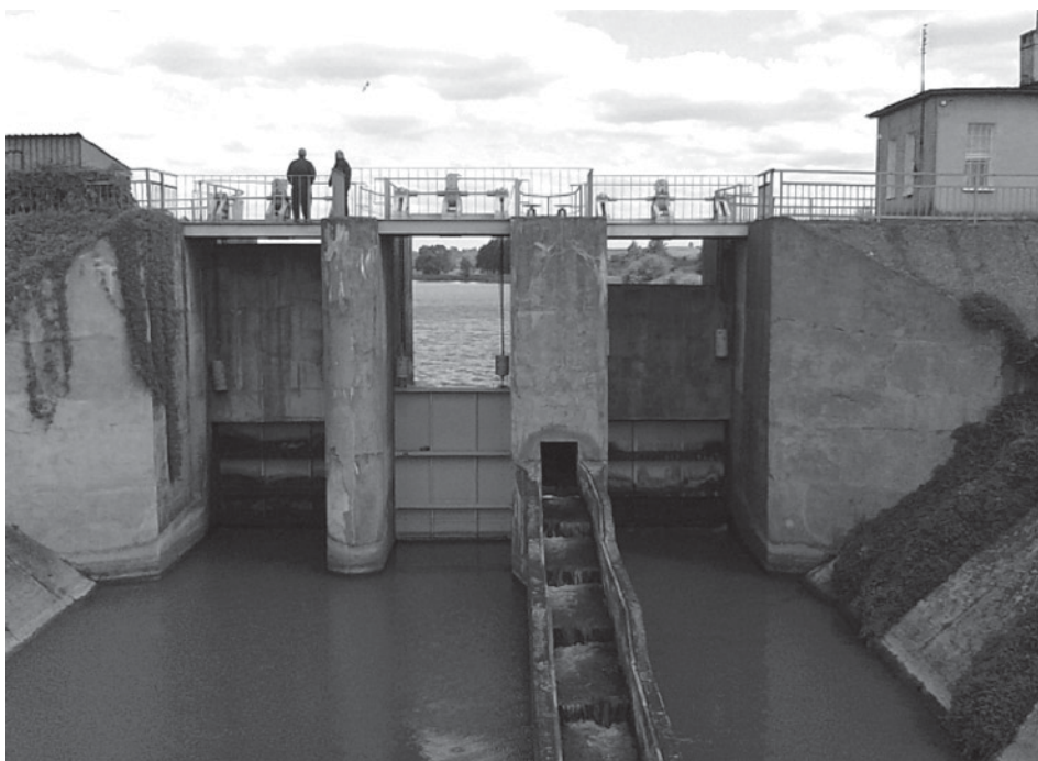
Rys. 2. Jaz zbiorników wodnych w Zesławicach na rzece Dłubni Fig. 2. The weir of the dam weir of the Zesławice water reservoirs on the river Dłubnia
