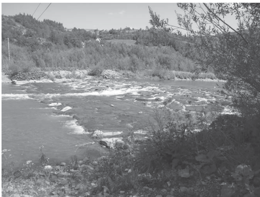
Rys. 5. Budowle hydrotechniczne bliskie naturze: a) przepławka na rzece Isar (Bawaria, Niemcy), b) rampa w potoku Porębianka
