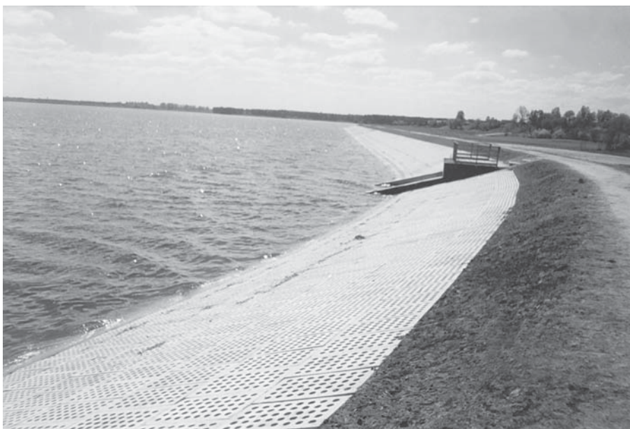
Rys. 3. Obwałowanie boczne ze śluzą Fig. 3. Side embankment with the sluice
