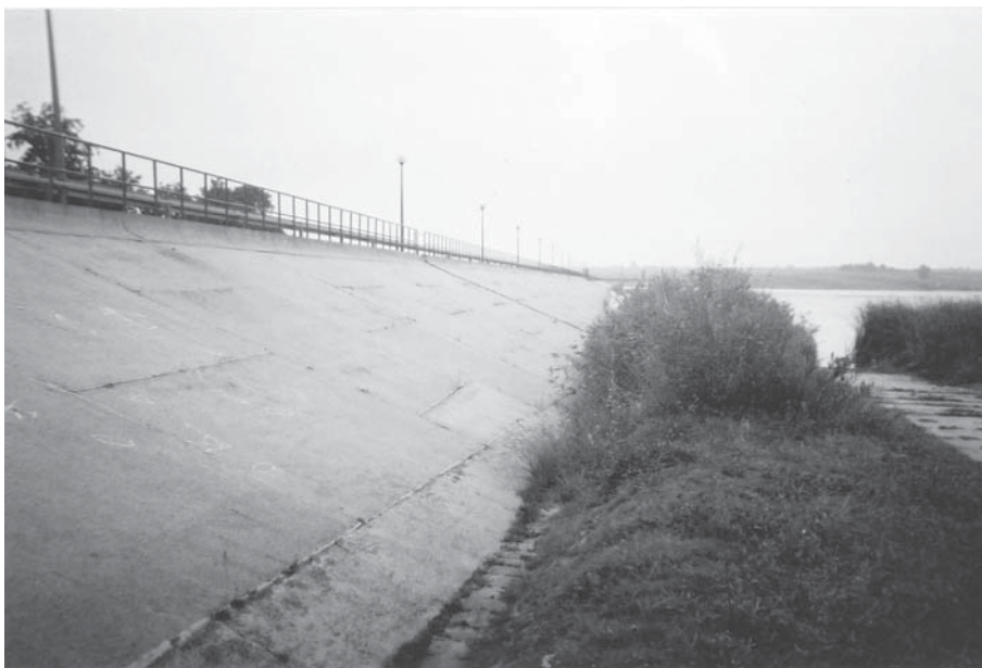
Rys. 2. Strefa przyczółkowa zapory czołowej Fig. 2. Abutment zone of concrete dam frontal
