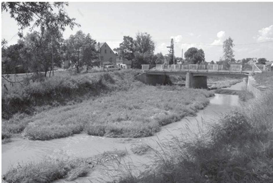
Rys. 1. Widok od strony wody górnej mostu drogowego w km 26+150 biegu rzeki Skorej Fig. 1. View from the upstream of the road bridge at km 26+150 of the Skora River course
