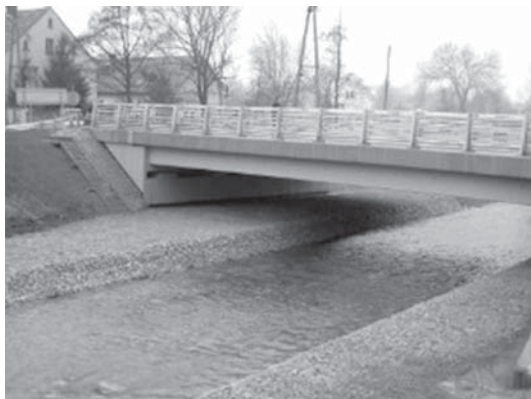
Rys. 14. Widok od strony wody górnej przebudowanego mostu drogowego
