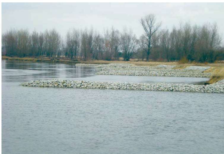
Ryc. 7. Odtworzenie zniszczonej zabudowy regulacyjnej na odcinku lewego brzegu rzeki Warty km 353,7 (fot. T. Kałuża)
