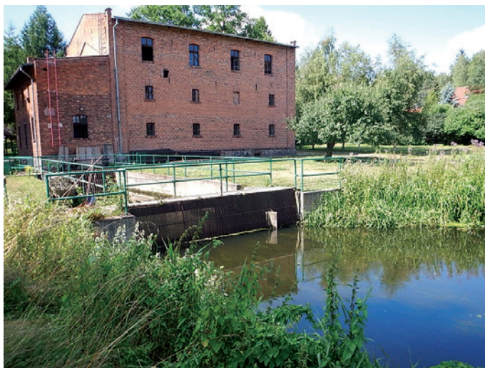
Ryc. 1. Mała elektrownia wodna na rzece Welnie w Jaraczu – widok na kratę wlotową Fig 1. Small hydroelectric power plant on the river Welna in Jaracz – view on the inlet grate
