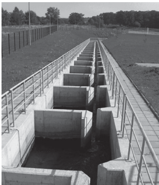
Rys. 1. Przepławka jednoszczelinowa na zaporze Kozielno Fig. 1. One-slot fishway (Vertical-Slot) at Kozielno dam
