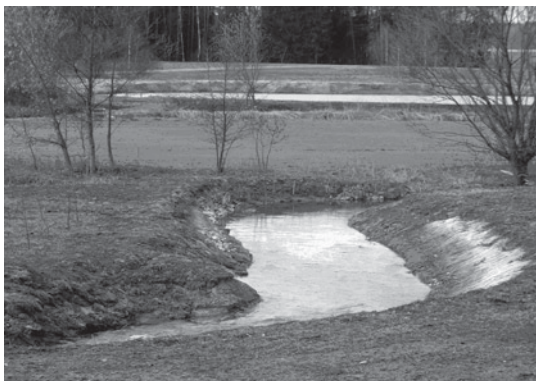
Rys. 5. Utworzony meander koryta rzeki Förritz z widocznym ubezpieczeniem z narzutu z kamienia łamanego [TMLNU 1996]
