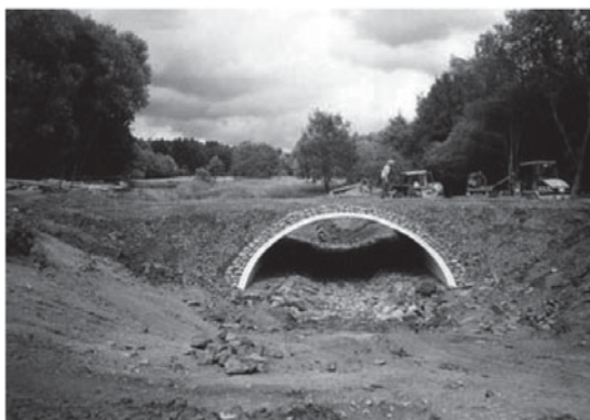
Rys. 6. Faza wykonywania przepustu na rzece Förritz [TMLNU 1996]
