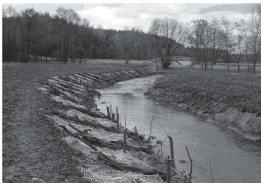
Rys. 4. Ubezpieczenie brzegu koryta rzeki Förritz za pomocą mat filtracyjnych oraz palisady [TMLNU 1996]
